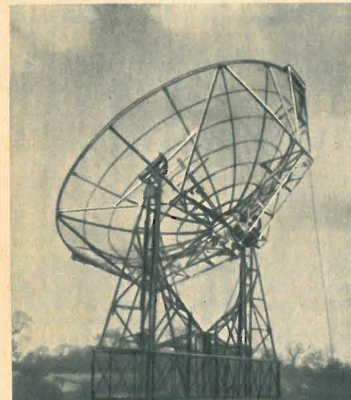
● Il paraboloide della Stazione di Godrell Bank (Inghilterra). Esso lavora su una larga banda di frequenze, potendo porre nel fuoco diversi aerei.
